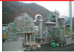
発電施設の改良
